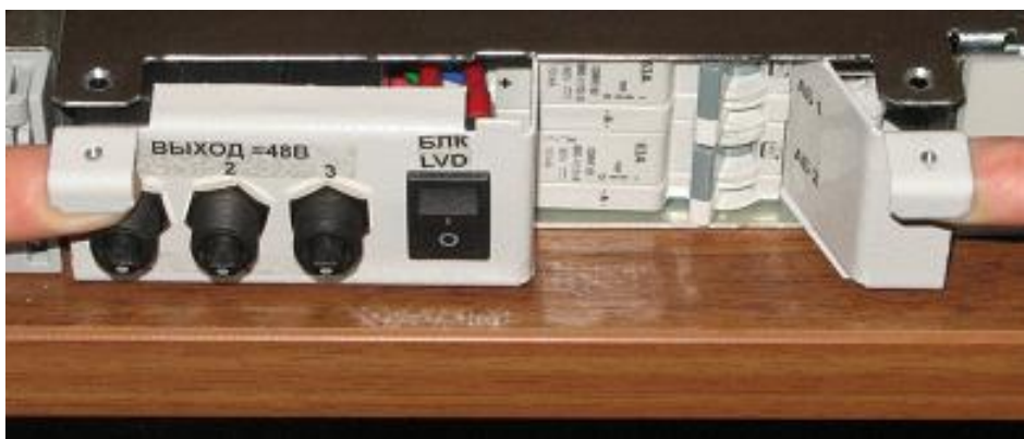
Рисунок 4.2 – Извлечение кронштейна с автоматическими выключателями
